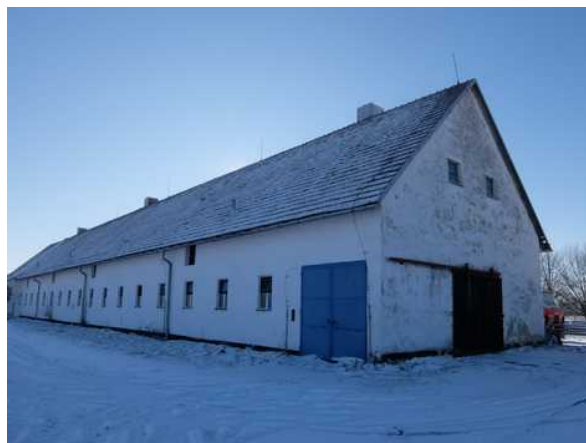
Zemědělská stavba č.1 - bývalý kravín
