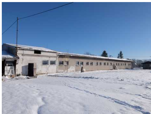
Zemědělská stavba č.2 - bývalý vepřín
