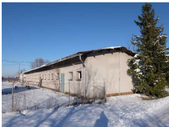
Zemědělská stavba č.2 - bývalý vepřín
