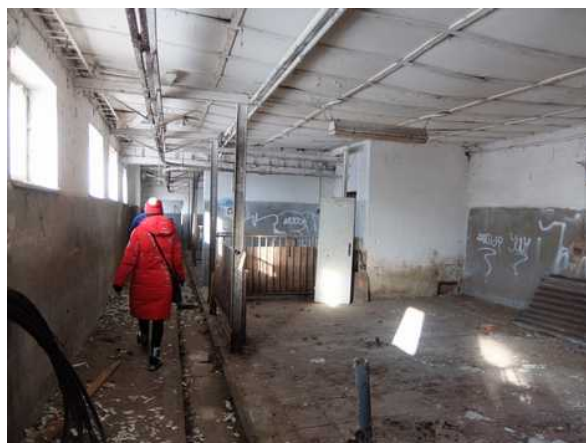
Zemědělská stavba č.2 - bývalý vepřín
