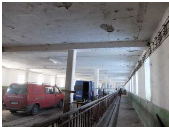
Zemědělská stavba č.1 - bývalý kravín
