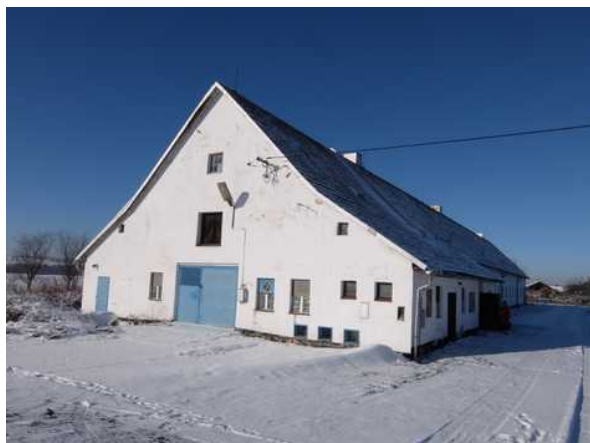
Zemědělská stavba č.1 - bývalý kravín
